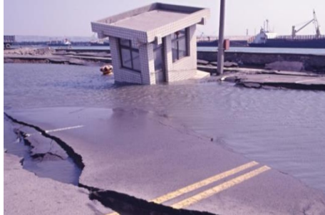
圖八 九二一大地震之後土壤液化(柯金源)
